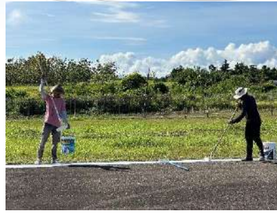
Pengecatan Marka Runway
