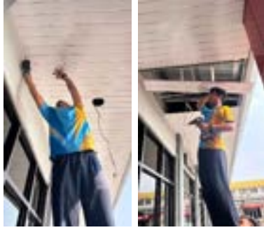
Pemasangan Plafon Terminal Kedatangan
