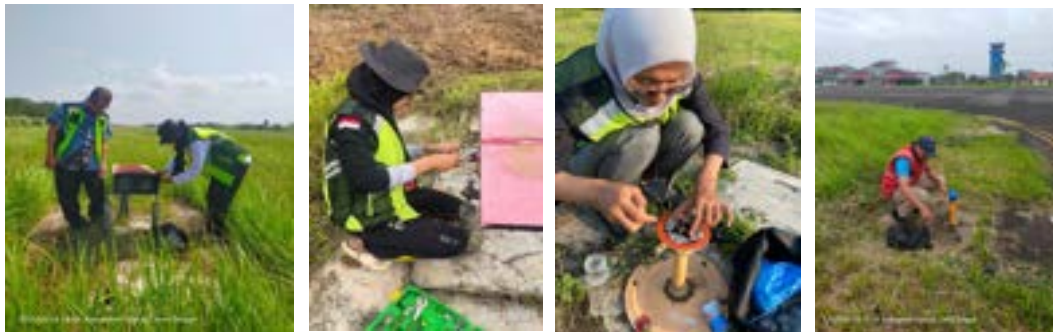
Penggantian Lampu PAPI, Lampu Runway dan Taxiway
