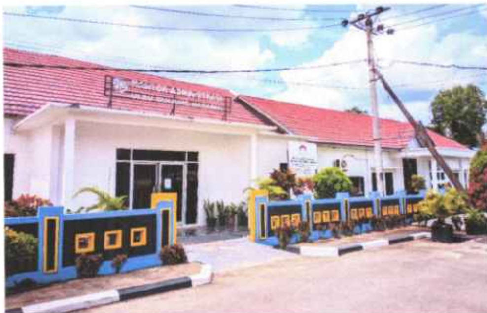
Gambar 2.14 Gedung Kantor Administrasi
