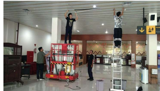
Perbaikan Plavon Terminal Keberangkatan
