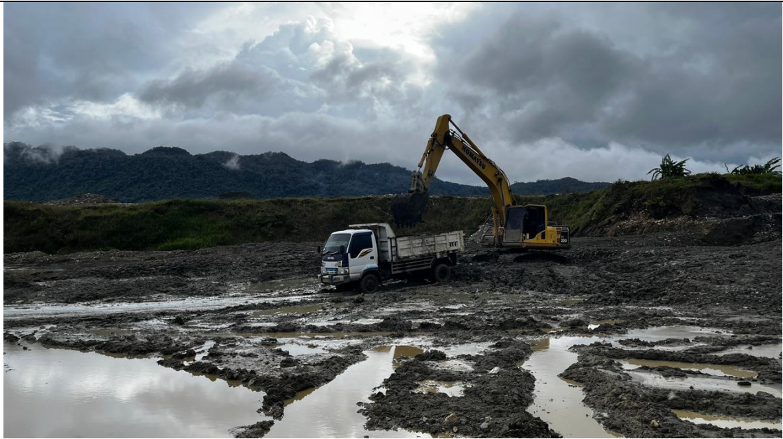
Pekerjaan Lanjutan Pemotongan Obstacle untuk Pemenuhan Standarisasi Runway Strip
