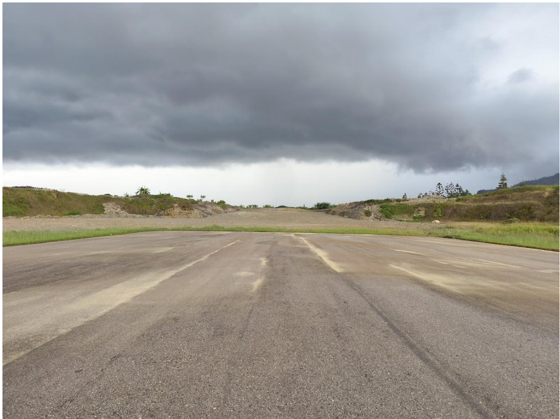
Hasil Pekerjaan Lanjutan Pemotongan Obstacle untuk Pemenuhan Standarisasi Runway Strip
