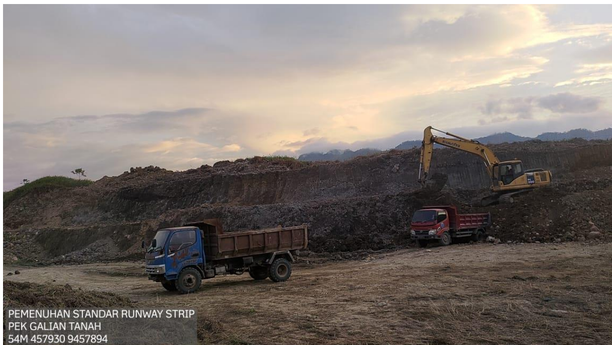
Gambar Kegiatan Pekerjaan Penyempurnaan Runway Strip Termasuk Pengawasan
