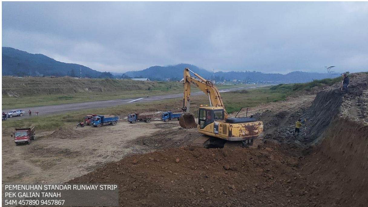
Gambar Kegiatan Pekerjaan Penyempurnaan Runway Strip Termasuk Pengawasan
