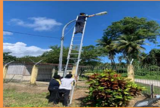
KEGIATAN PERBAIKAN LAMPU PENERANGAN JALAN
