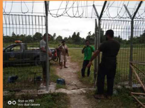
PEMBUATAN PINTU PAGAR PERIMETER
