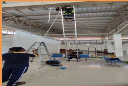
KEGIATAN PEMASANGAN KIPAS ANGIN DI RUANG TUNGGU TERMINAL
