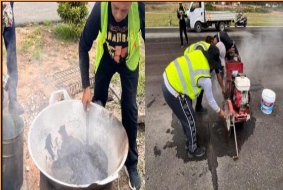
KEGIATAN PATCHING PADA RUNWAY BANDAR UDARA LETUNG
