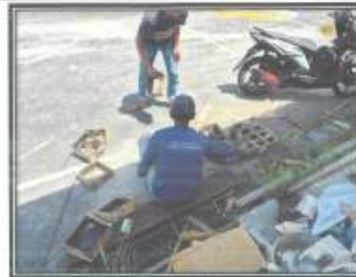
Pembuatan Patch kabel
