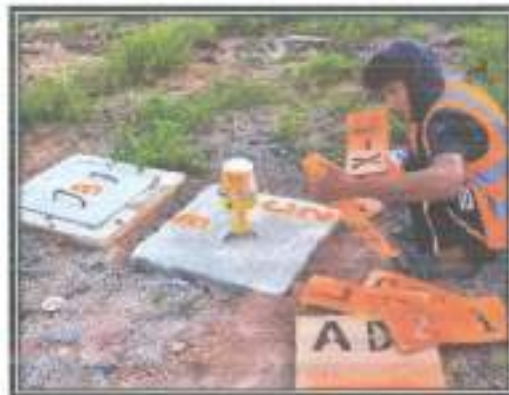
Pemasangan lampu AFL
