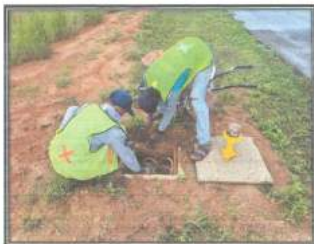
Repair Bak trafo
