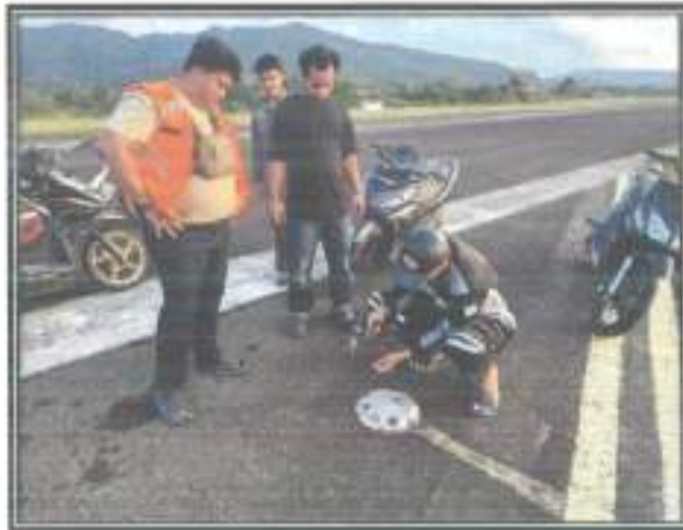
Instalasi lampu inlet
