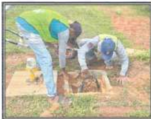
Repair Bak trafo
