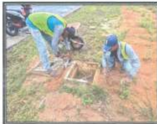
Repair Bak trafo
