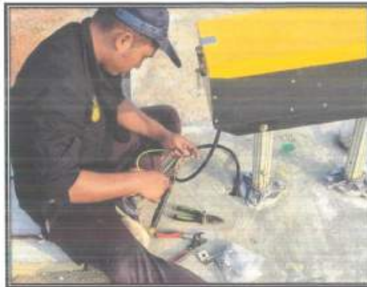
Pemasangan skin Grounding PAPI
