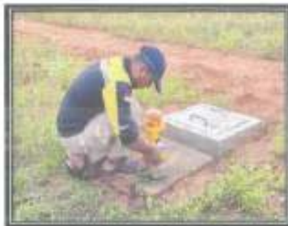
Pemasangan drum Grounding
