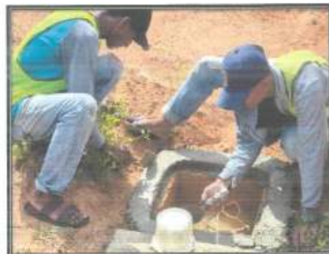
Repair Bak trafo
