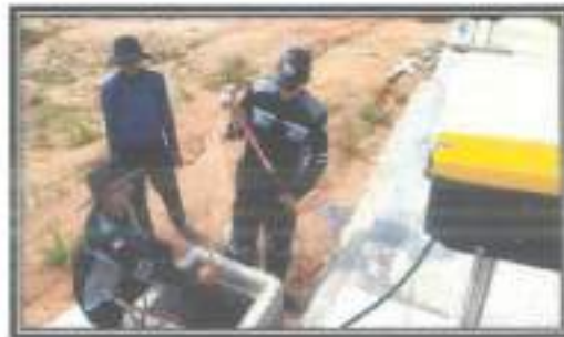
Pemasangan Copper rod
