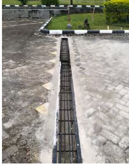
Pembuatan saluran air di halaman parkir
