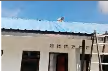
Perbaikan kebocoran atap mess tipe I
