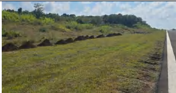
Tapping tanah padat beda tinggi penutup drainase dan shoulder sisi utara runway
