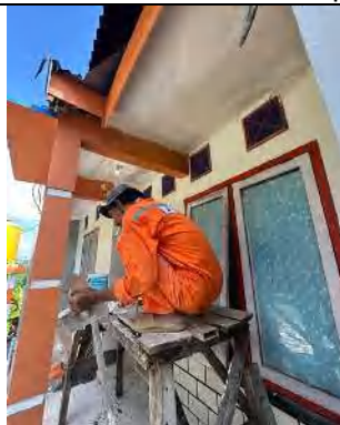
Perbaikan Plafon rumdis tipe 36
