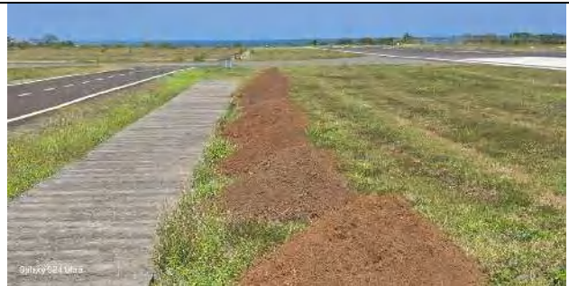
Tapping tanah padat beda tinggi penutup drainase dan shoulder sisi timur taxiway
