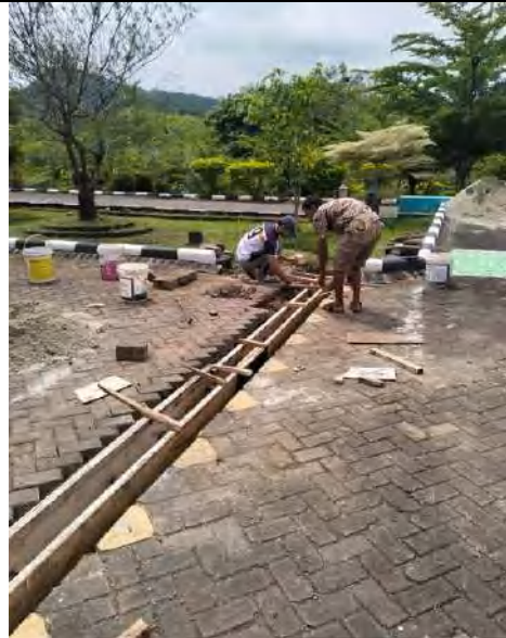
Pembuatan saluran air di halaman parkir
