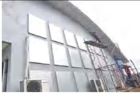
Pengecatan ulang ged.terminal bagian sisi barat
