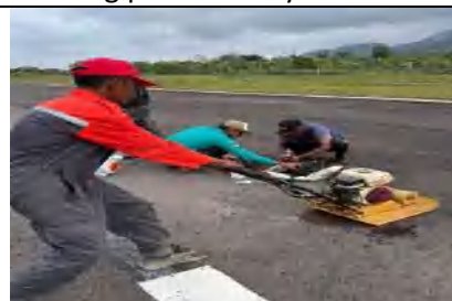
Patching pada runway
