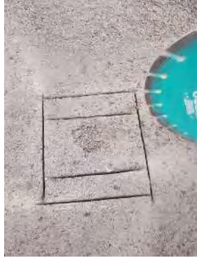
Patching pada runway
