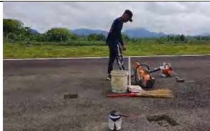
Patching pada runway
