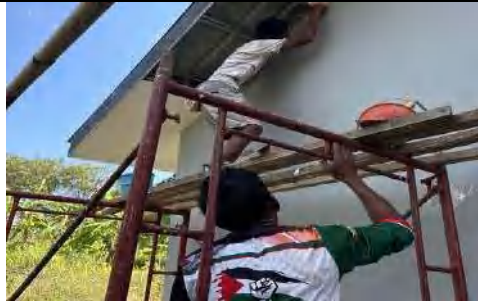
Perbaikan plafon mess tipe I
