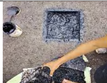
Patching pada runway
