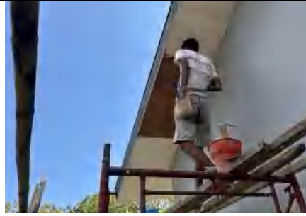
Perbaikan plafon mess tipe I
