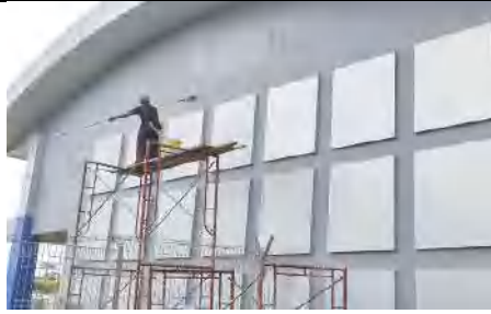
Pengecatan ulang ged.terminal bagian sisi barat
