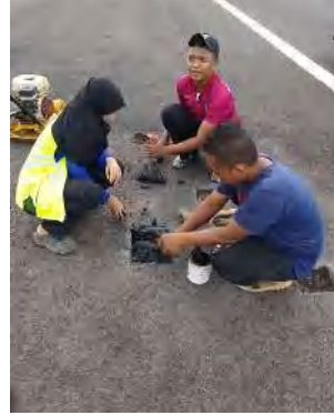
Patching pada runway
