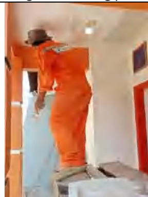
Perbaikan Plafon rumdis tipe 36
