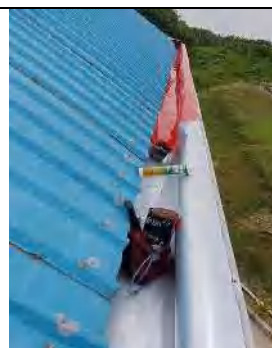
Perbaiki talang air ged. Terminal bagian sisi utara
