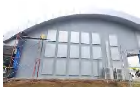
Pengecatan ulang ged.terminal bagian sisi timur
