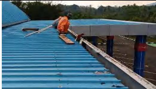
Perbaiki Talang air ged. terminal bagian selatan
