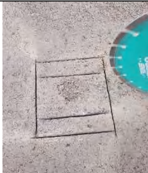
Patching pada runway
