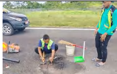
Patching pada runway
