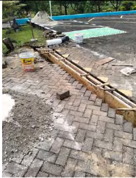
Pembuatan saluran air di halaman parkir
