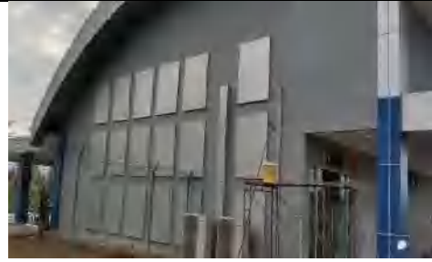
Pengecatan ulang ged.terminal bagian sisi timur
