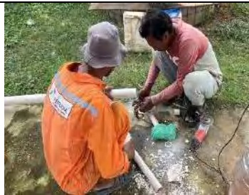
Perbaikan kebocoran jalur air wastafel mess tipe I
