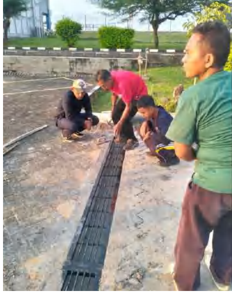
Pembuatan saluran air di halaman parkir
