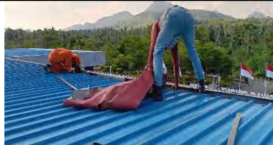
Perbaiki Talang air ged. terminal bagian selatan
