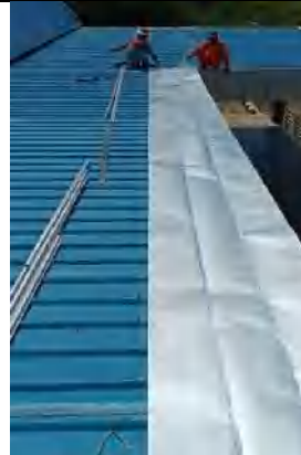
Perbaiki Talang air ged. terminal bagian selatan
