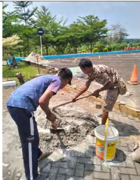
Pembuatan saluran air di halaman parkir
