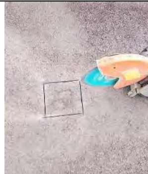
Patching pada runway
