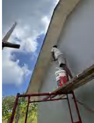
Perbaikan plafon mess tipe I
