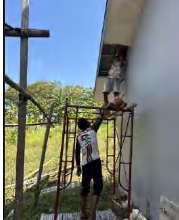
Perbaikan plafon mess tipe I
