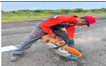
Patching pada runway
