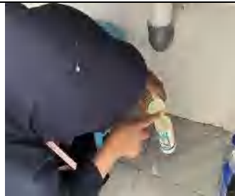
Perbaikan kebocoran jalur air wastafel mess tipe I
