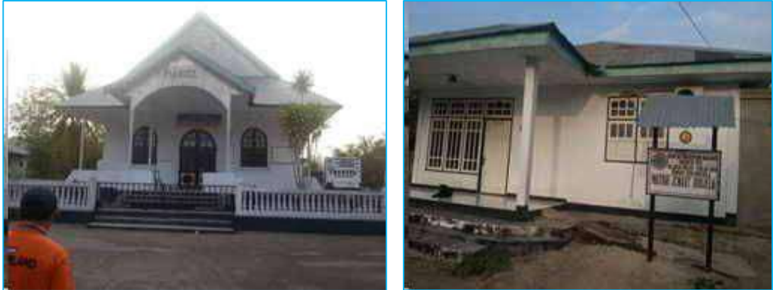
Gambar 3. 4 Gereja dan Pastori di Lokasi Proyek
