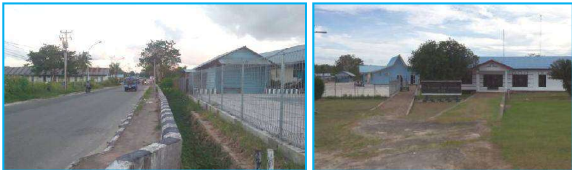
Gambar 2. 14 Jalan Penghubung di Kawasan Bandara
