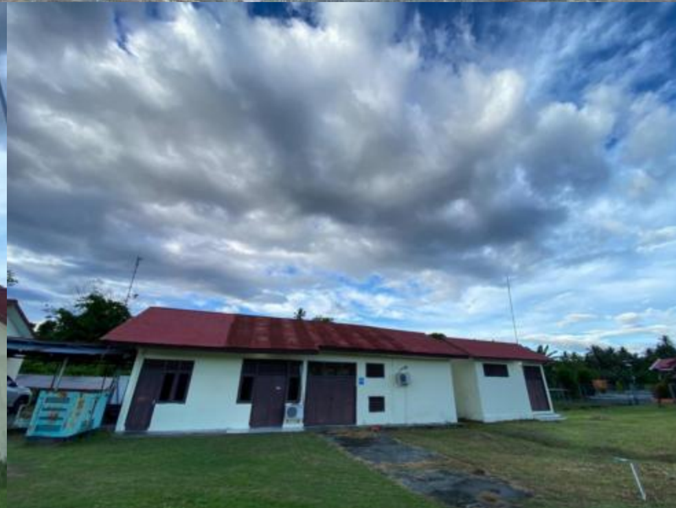
GEDUNG POWER HOUSE
