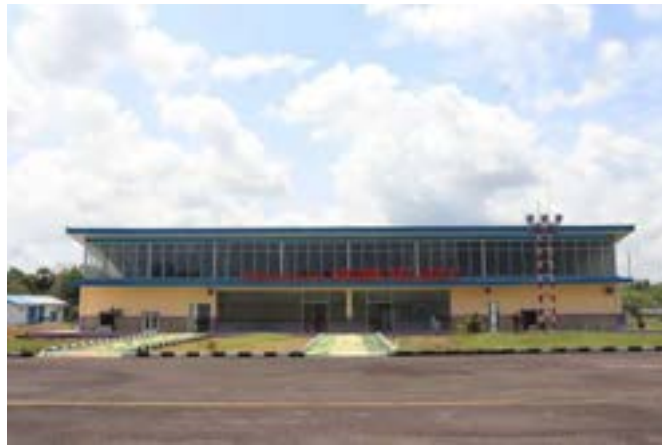
TERMINAL PENUMPANG (TAMPAK SISI UDARA)
