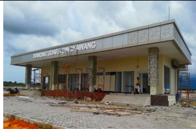
Pembangunan Bandar Udara Singkawang
