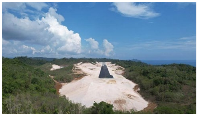
Pebangunan Bandar Udara Banggai Laut
