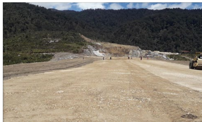
Pembangunan Bandar Udara Sobaham
