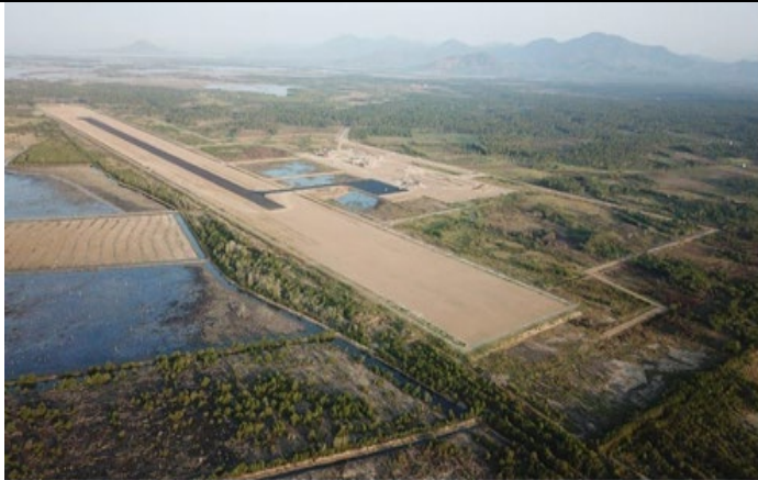
Pembangunan Bandar Udara Pahuwato
