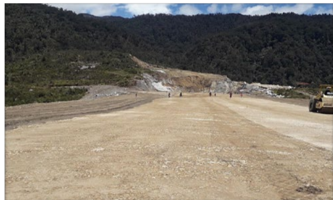
Pembangunan Bandar Udara Sobaham
