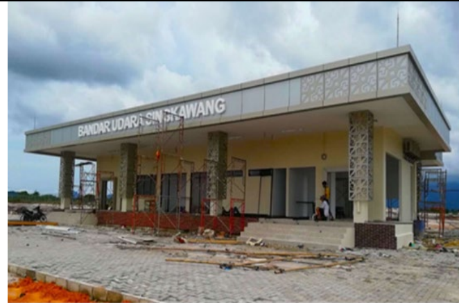
Pembangunan Bandar Udara Singkawang
