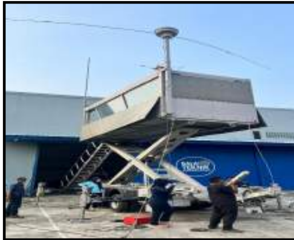
Perawatan dan Perbaikan Mobile ATC
